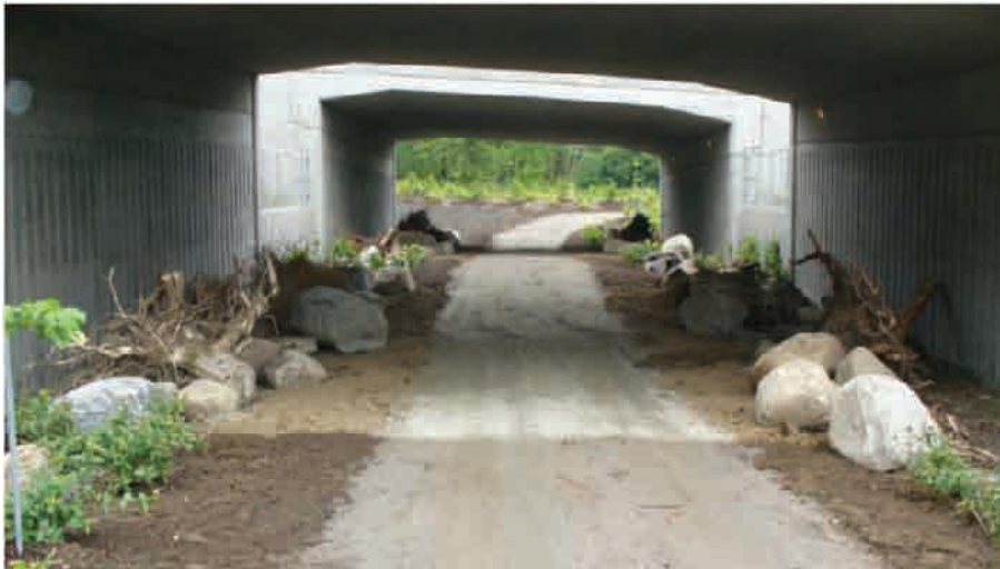
Photographie #5 Tunnel mixte - boulevard Robert-Bourassa à Québec
