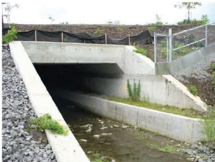
Photographie #4 Ponceau à deux niveaux - boulevard Robert-Bourassa à Québec
