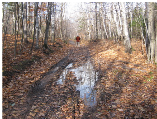
Ancien chemin d'accès à la résidence d'été des Sœurs de Notre-Dame du Bon Conseil, raviné par le passage d'un véhicule tout terrain
