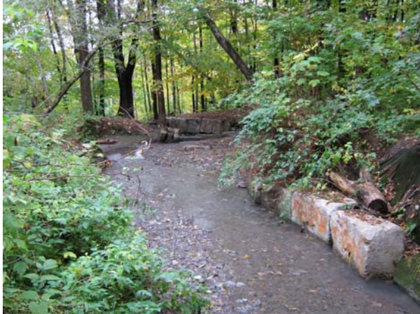
Blocs de béton disposés pour retenir la berge du ruisseau Lallemand dans sa portion aval
