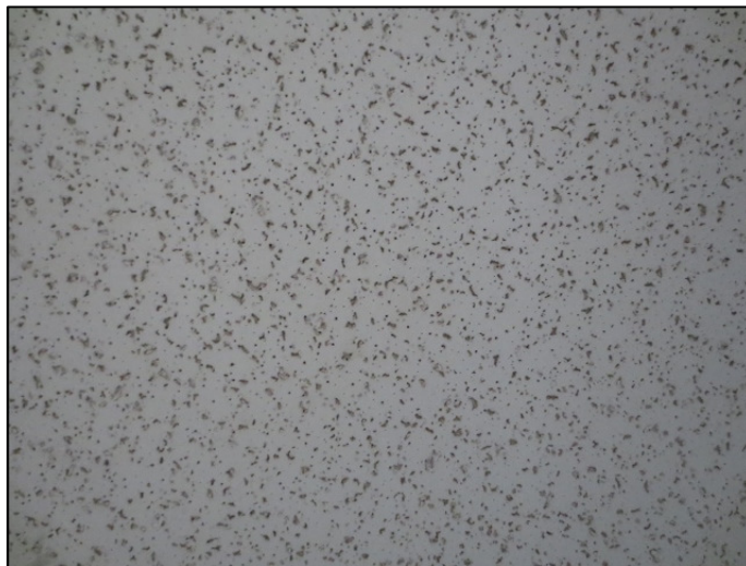
Photo 3 – Carreau de plafond de 2 pi sur 4 pi blanc picoté et strié en cercles, sans amiante
