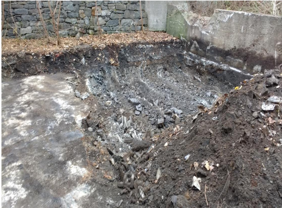
Photo 6 - Début de l'excavation EX-3 (mur de soutènement en béton et muret de pierre visibles).
