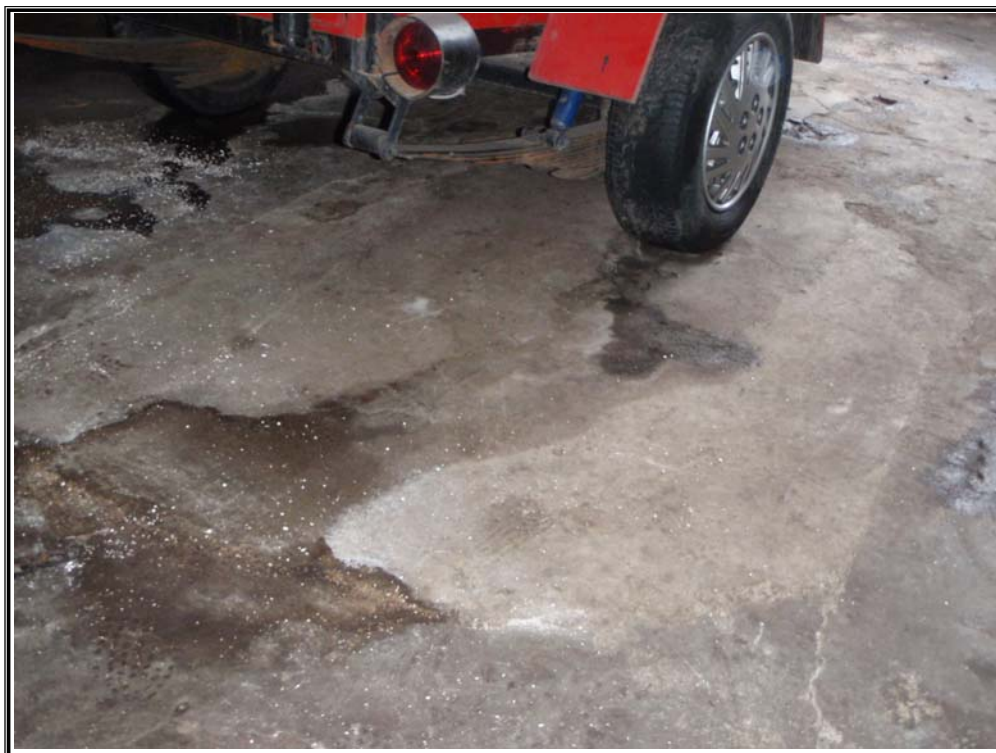
PHOTO 2 : Emplacement de l'ancien cylindre souterrain.
