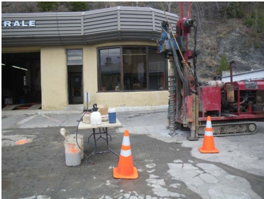
Photo 6 : Foreuse en opération au forage F11-5
