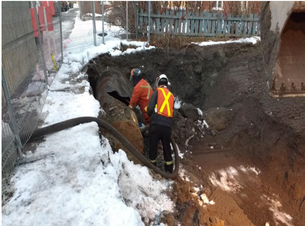
Photo 3 - Nettoyage du réservoir souterrain par la firme Véolia.
