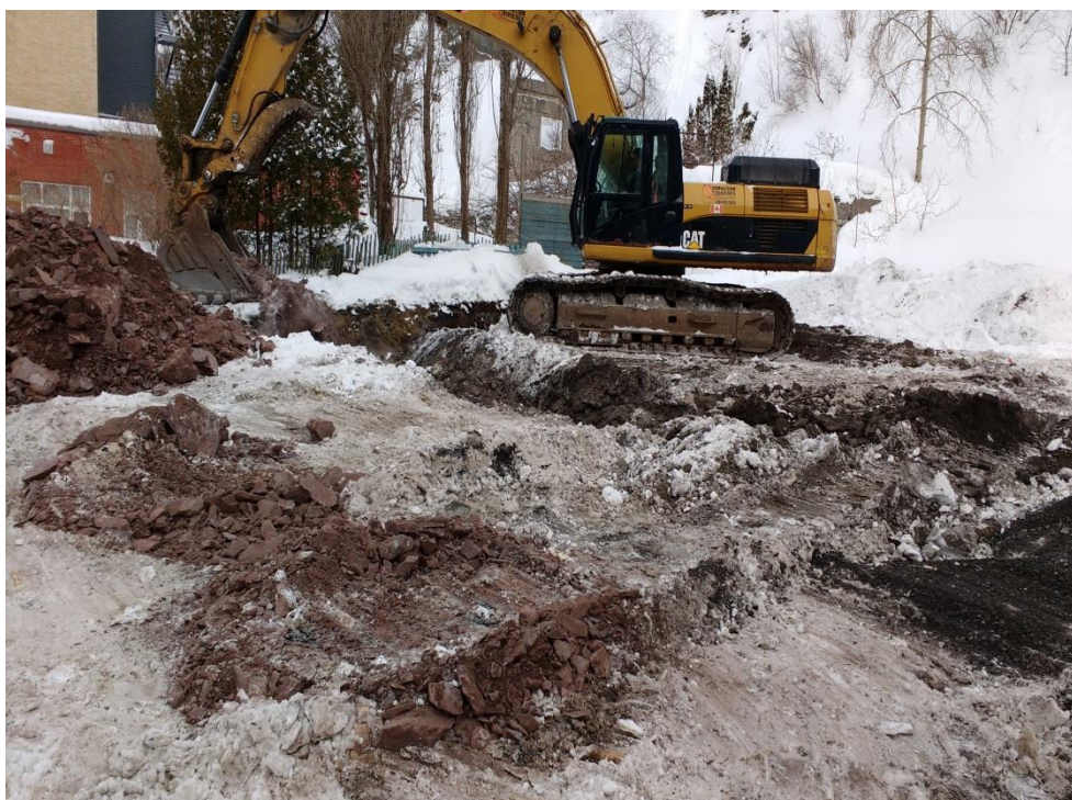
Photo 12 - Surexcavation de l'excavation EX-4.
