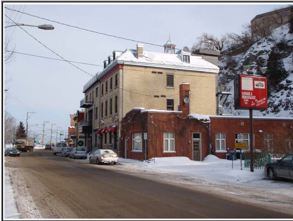
PHOTO 5 : Bâtiments commerciaux et résidentiels au nord du "Site".
