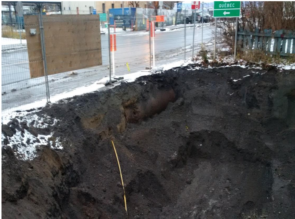
Photo 2 - Réservoir souterrain découvert en réalisant l'excavation EX-1.
