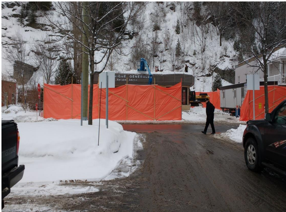
Photo 9 - Démolition du bâtiment sous enceinte (désamiantage).
