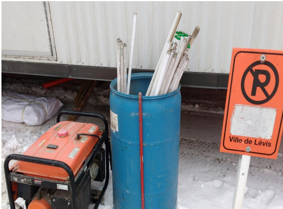
Photo 10 - Tubes fluorescents entreposés temporairement sur le Site.
