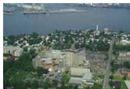
vue aérienne du site de l'Hôtel-Dieu
