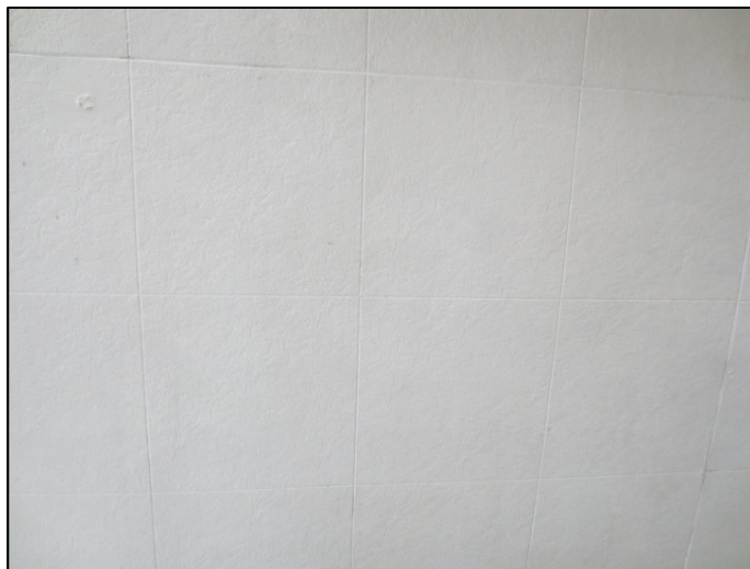
Photo 2 – Carreau de plafond de 4 pi sur 4 pi à motifs de carreaux de 1 pi 2 blancs lignés, sans amiante
