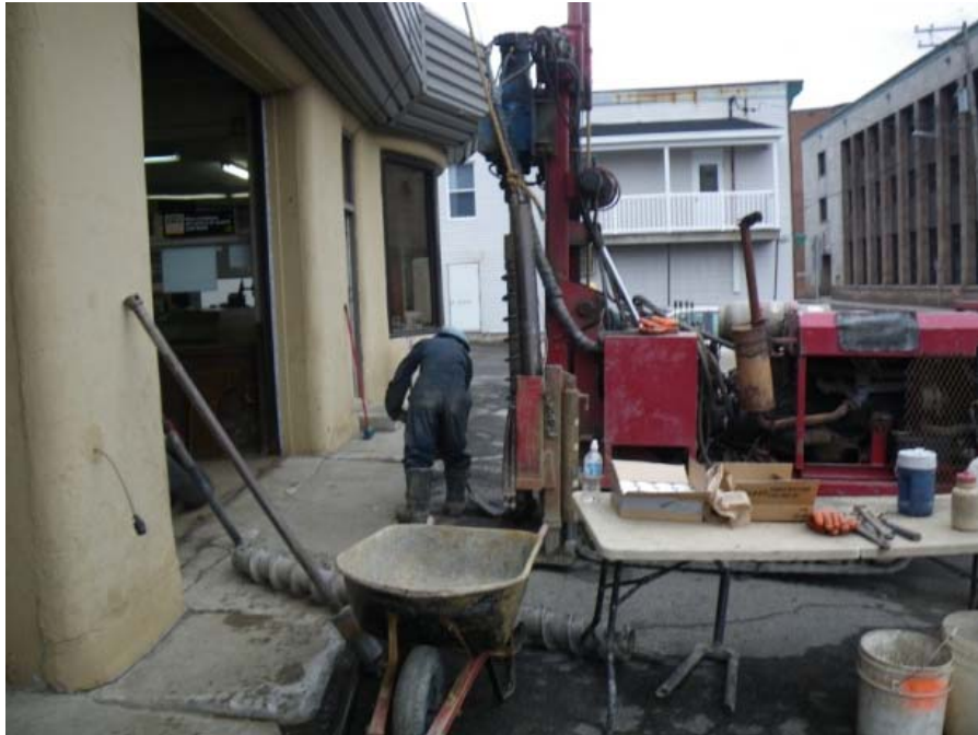
Photo 7 : Foreuse en opération au forage F11-6
