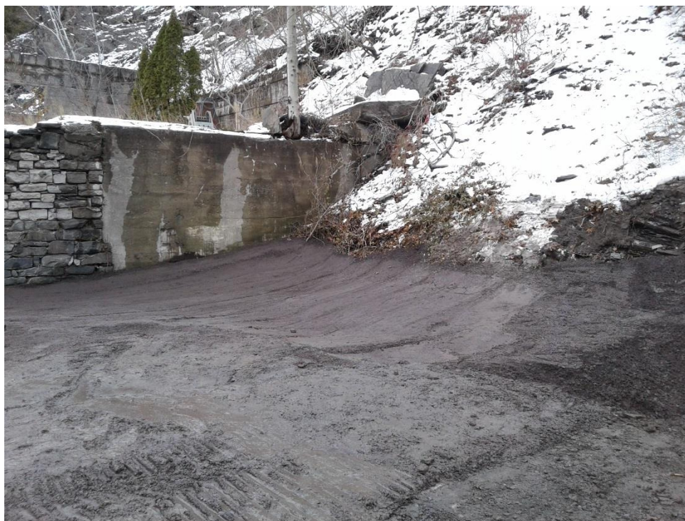
Photo 15 - Excavation remblayée par l'entrepreneur avec muret de béton démolé.
