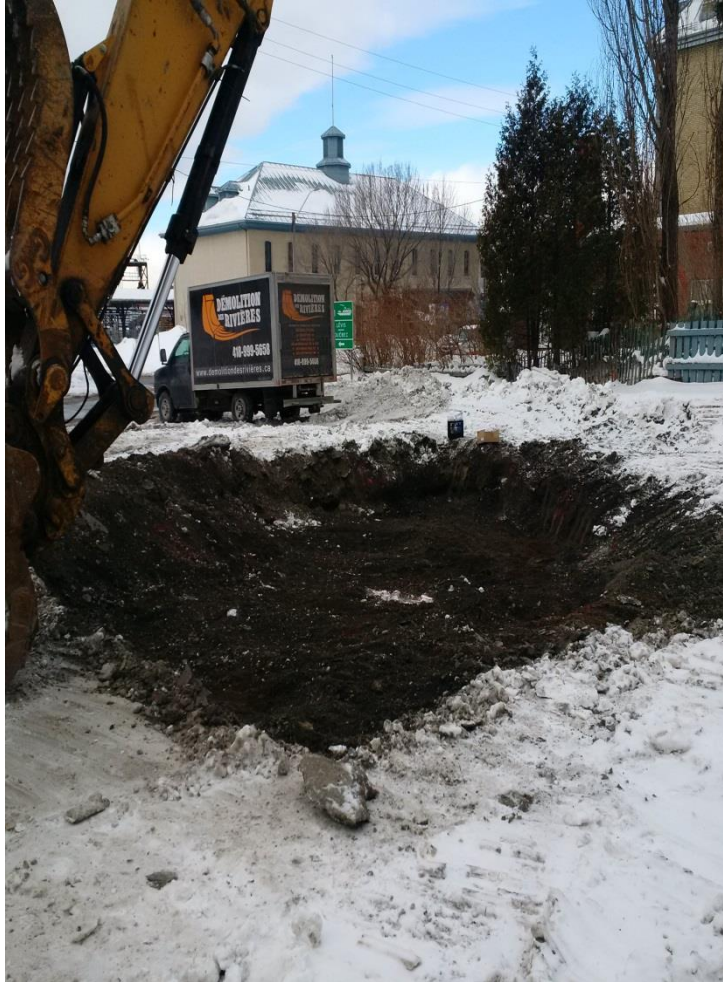
Photo 11 - Début de l'excavation EX-4.
