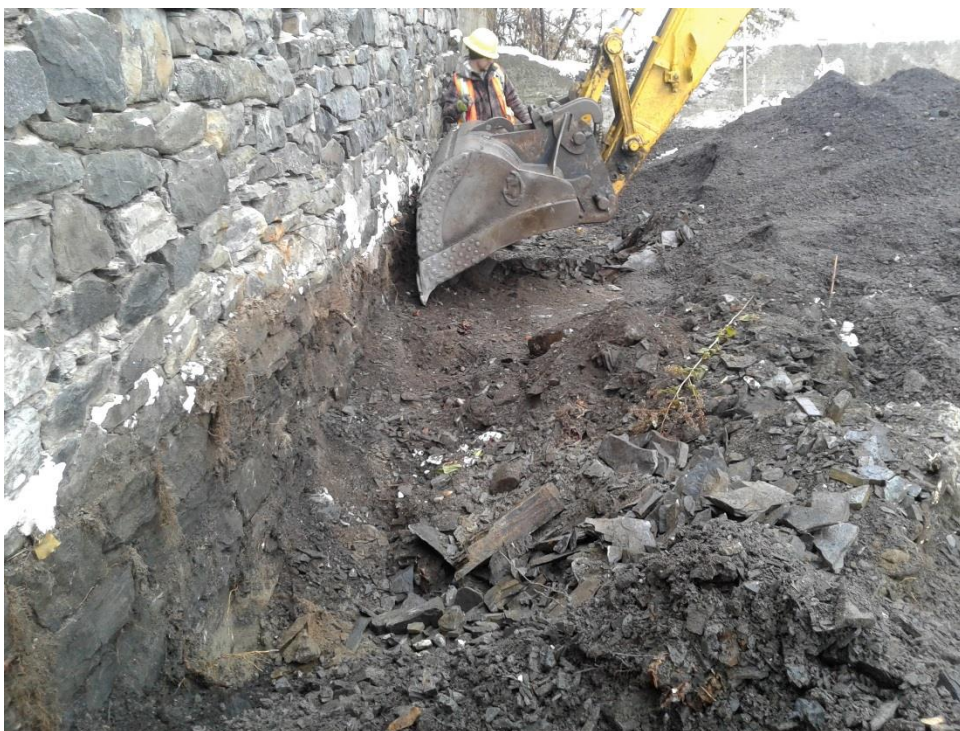
Photo 13 - Surexcavation le long du mur de pierre qui repose sur le roc (EXC-3/PA-13).
