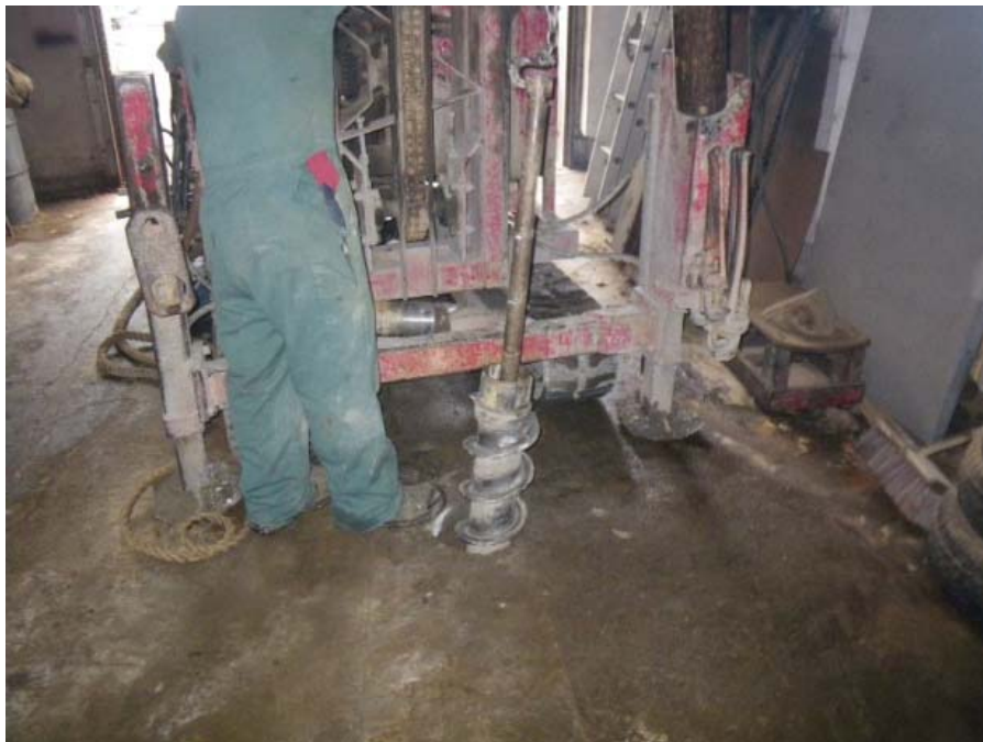
Photo 8 : Foreuse en opération au forage F11-7
