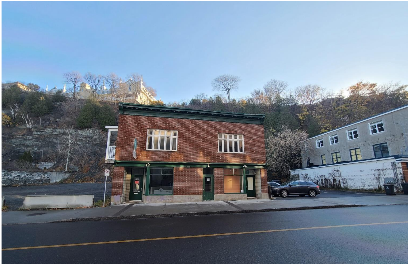
Photo 10 : Bâtiment à démolir, bas de la falaise
