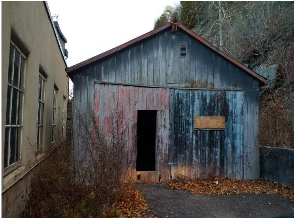
Photo 1 - Hangar sur le Site avant son démantèlement.
