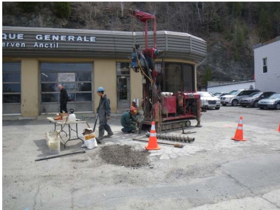
Photo 4 : Foreuse en opération au forage PO11-3
