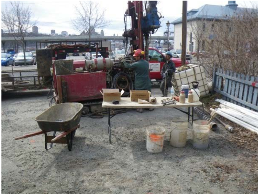
Photo 5 : Foreuse en opération au forage F11-4
