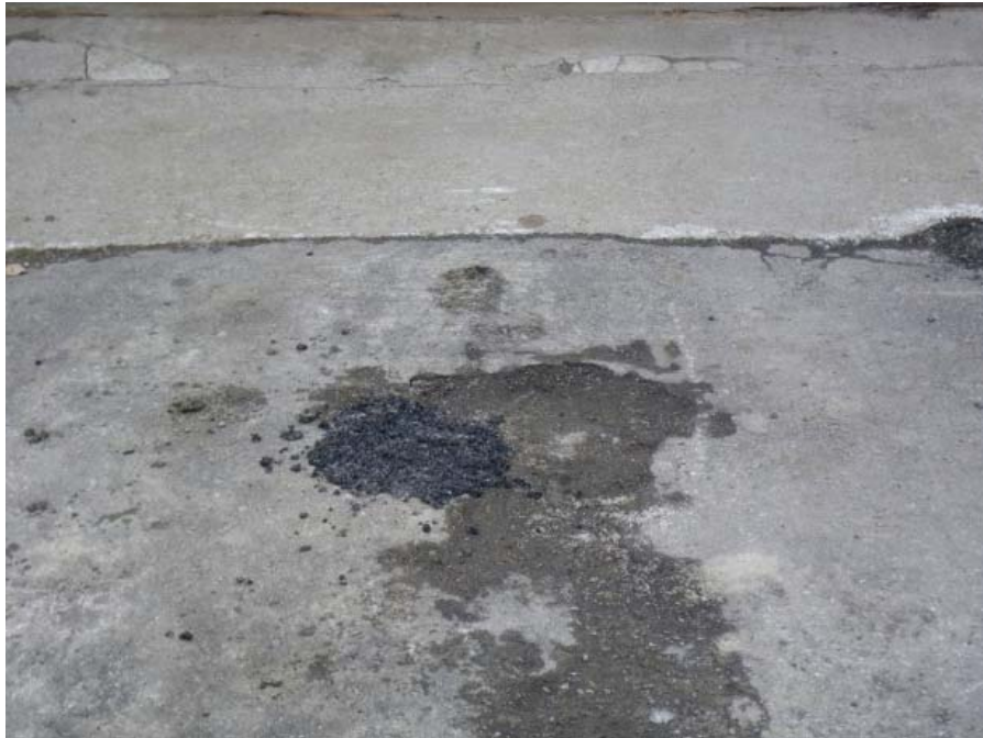
Photo 9 : Mise en place d'asphalte froide à l'endroit du forage F11-6
