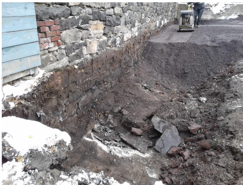
Photo 14 - Remblayage de l'excavation le long du mur de pierre.
