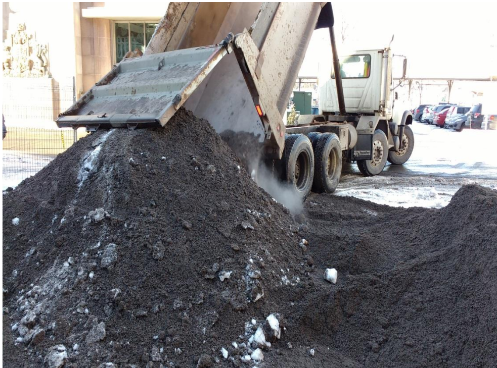
Photo 8 - Remblai des excavations EX-1 et EX-2.
