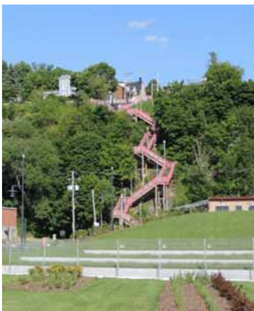
vue de l'escalier rouge depuis le quai Paquet
