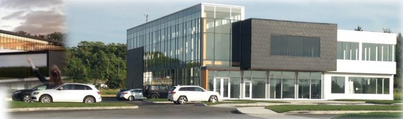
Nouveau bâtiment de Lesva
