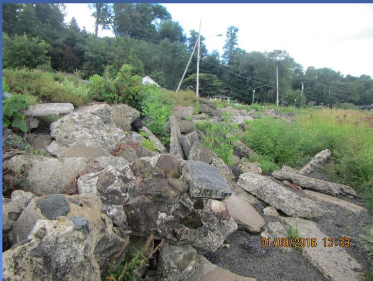
Stabilisation de talus à l'aide de matériaux artificiels
